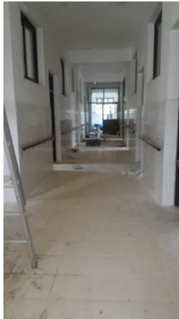
長い廊下の両側にお部屋があるタイプの病棟です
