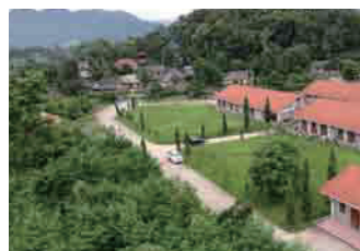
建設予定地 (建物は既存の県立病院)
